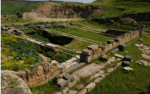
Figura 12. Mezquita omeya de Abila. Vista desde el NO del muro occidental y la entrada, que muestra la disposición de los cimientos de las arcadas y los muros que faltan.
