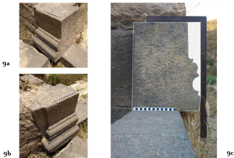
Figuras 9 a-c. Mezquita de Abila. Perfiles de las bases de las pilastras de las jambas.
